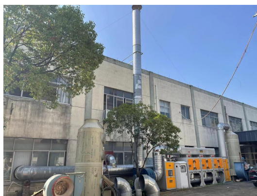
水喷淋+干式过滤器+催化燃烧一体机废气处理设施
